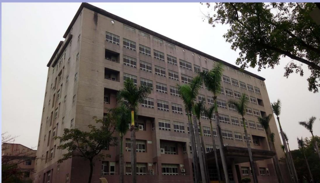
行政大樓外牆現況
