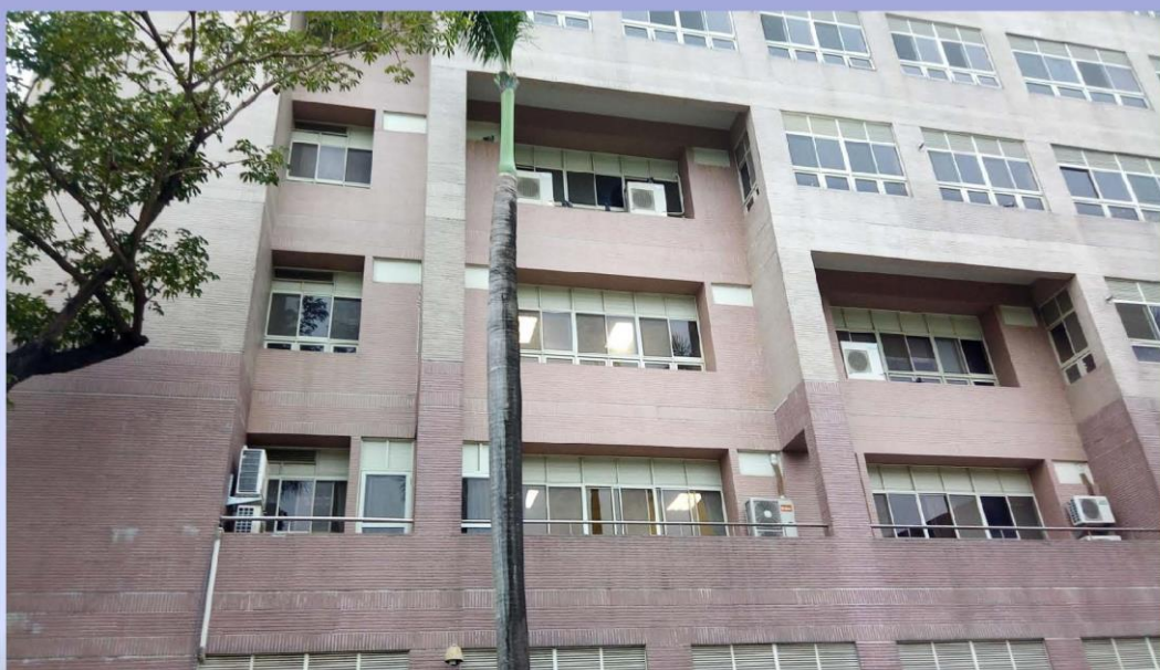
行政大樓南側挑高透空樓層現況
