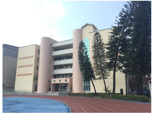
林森校區科學館 完工情形
