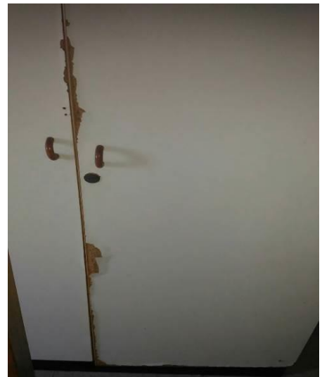
寢室衣櫥毀損
